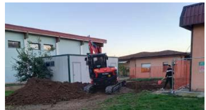
Uno scorcio del cantiere per la realizzazione della mensa
